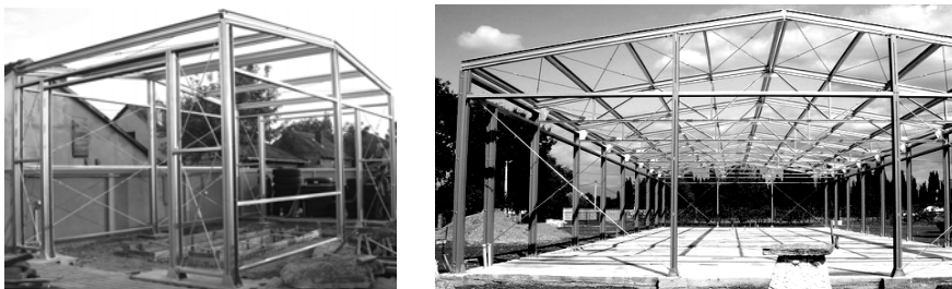
Слика 6. Изведене носеће конструкције монтажних хала
