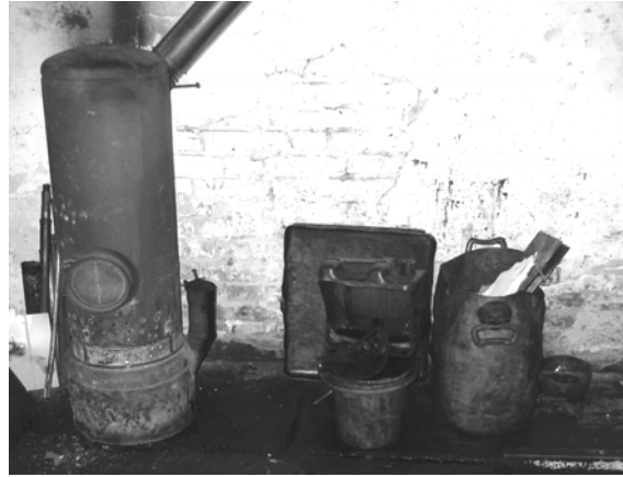
Sl. 1. Improvizovana peć ručne izrade na čvrsto gorivo sa dodatkom za ulivanje otpadnog ulja (cev sa donje desne strane). Koristi se za zagrevanje radionice.
