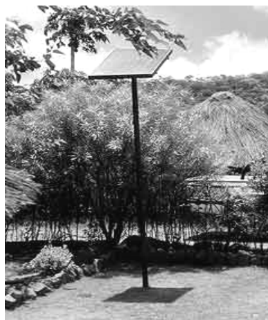
Sl. 1: Solarni panel instalisan u ruralnoj oblasti
